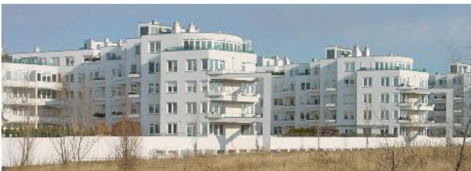
Polyfunkční dům Högerova – Štěpařská č.p. 1098, Praha 5 - Barrandov 209 bytových a nebytových jednotek, 337 gar. stání, 6.834 m2 komerčních prostor
