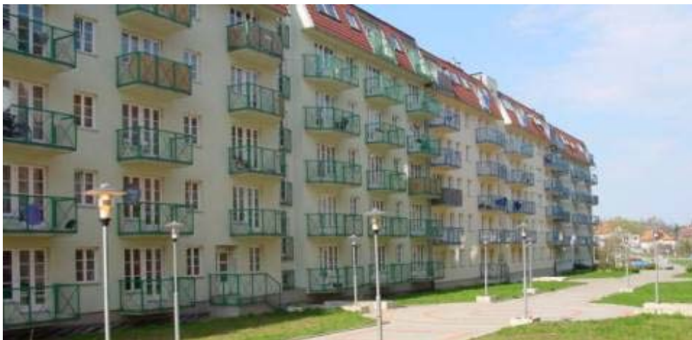
Bytový areál „Na hrádku“, ul. Pelušková – Lipnická, Praha 9 – Kyje 360 bytových a nebytových jednotek a 282 garážových stání
