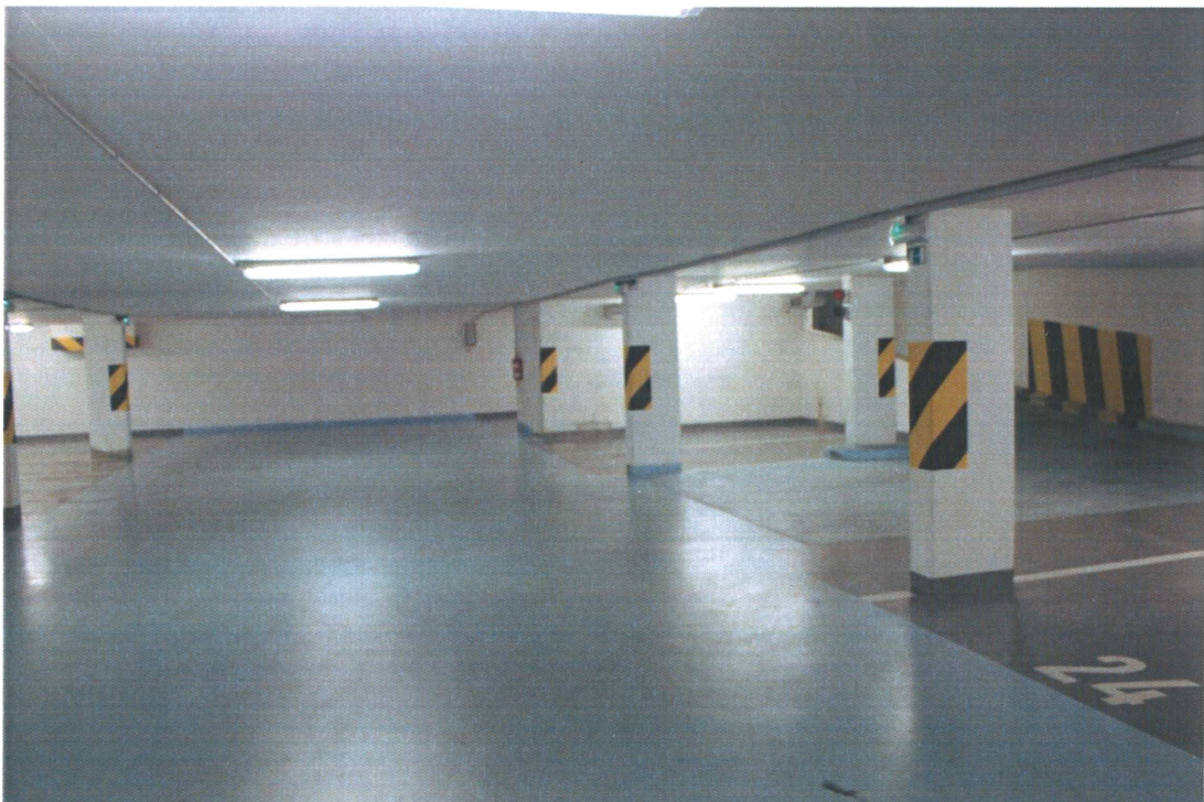
Pohled na prostory garáže 1. PP.
