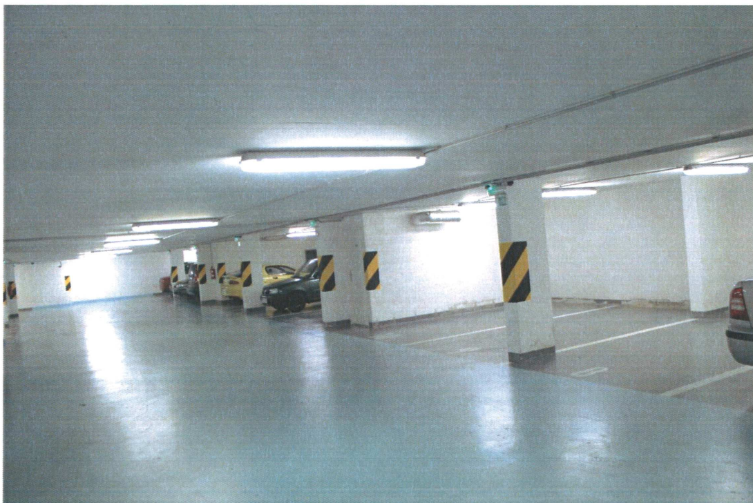
Celkový pohled na podzemní garáže v 2. PP.
